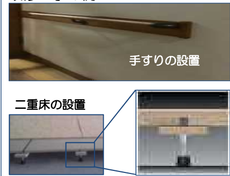
改修工事の例
