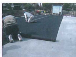
防水シート敷設
