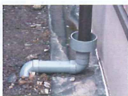
雨水管設置状況
